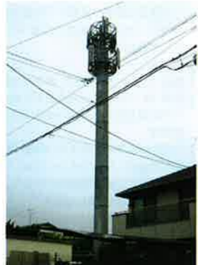
住宅地に立つ携帯電話の電波中継塔
